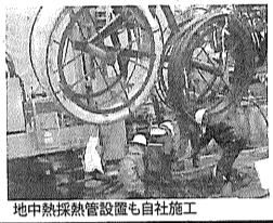
地中熱採熱管設置も自社施工
