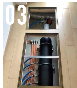
03 貯水ヘッダー、 Phyn Plus(漏水検知器)
