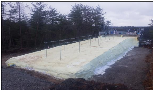
2月26日工事完了（ウレタン盛土）
