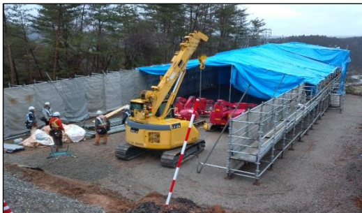
2月20日工事状況（雨養生テント）
