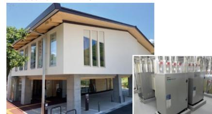
・除湿型放射冷暖房パネルの採用(熱源:地中熱ヒートポンプ)
