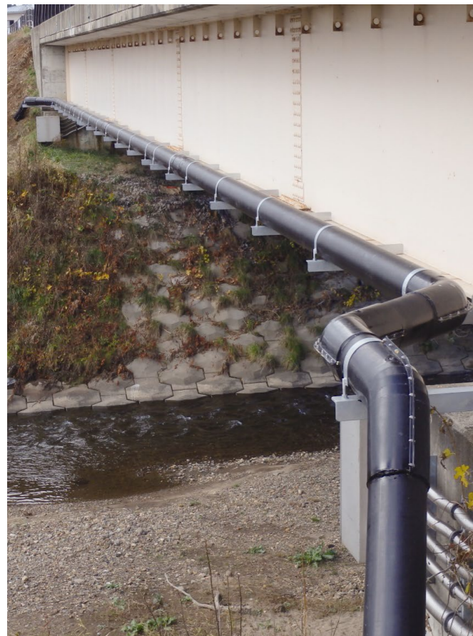
橋梁地覆下配管
