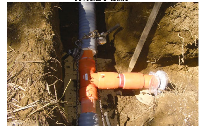
分岐継手接続
