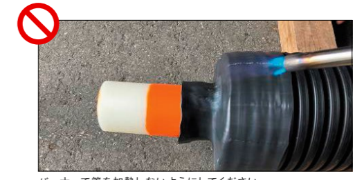
バーナーで管を加熱しないでください。
