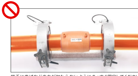
継手に曲げなどの力が加わらないようにまっすぐ固定してください。
