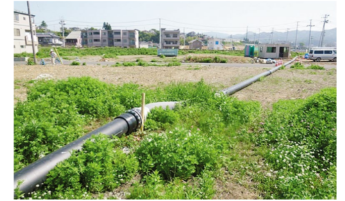
仮設下水配管 (東北震災復興)
