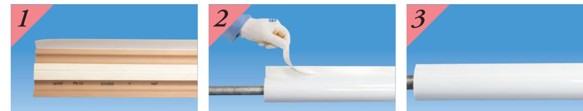
① 適管サイズのパイプガードを選び2つ割になる様左右に押し開きます。
