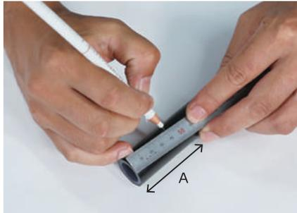
管端より規定の挿し込み長さの位置に標線を記入します。
