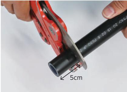
融着する管の管端より5cm程度の位置で、管軸に対して直角に切断します。
