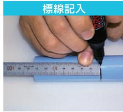
管端より被覆層をカットする長さで標線を記入します。下記のカット長さの目安を参照願います。
