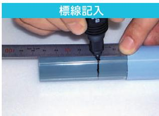
溶剤浸透防止層をカットする長さで標線を記入します。下記のカット長さの目安を参照願います。
