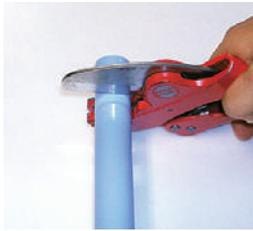
切断箇所にマジックインキ等で、標線を記入します。パイプカッターで標線に沿って管軸に直角に切断します。
