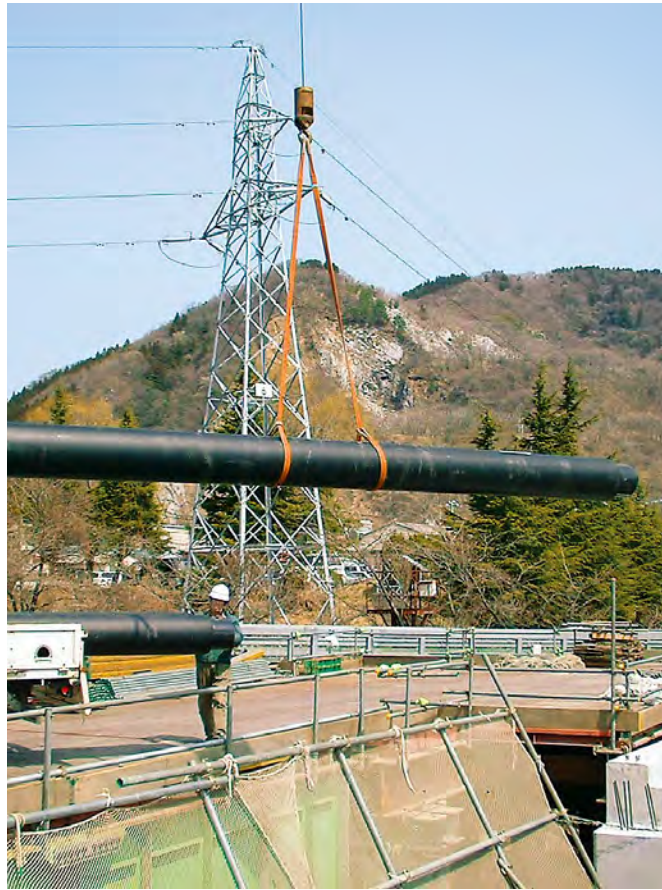
パイプ吊込状況
