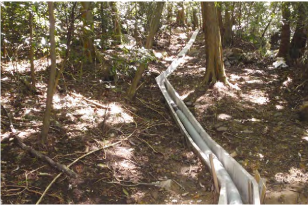
トラフ内配管
