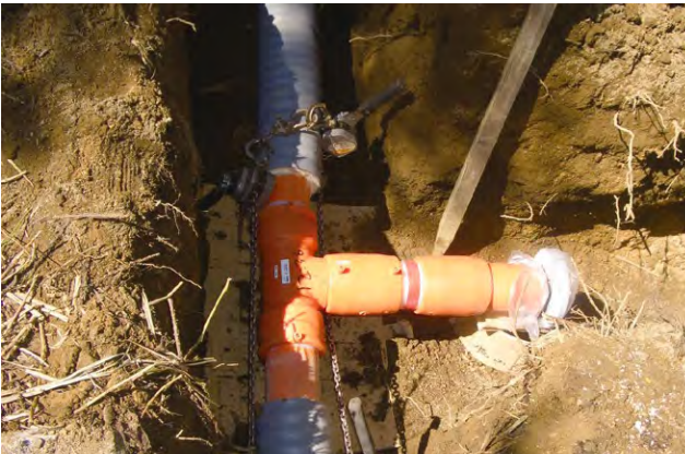
分岐継手接続
