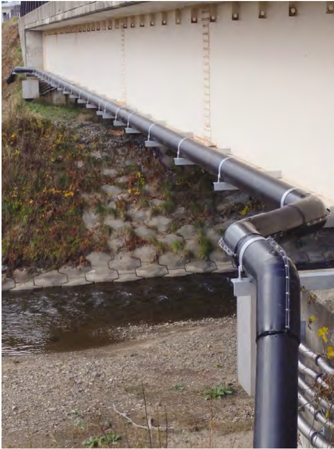
橋梁地覆下配管
