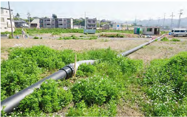
仮設下水配管 (東北震災復興)
