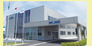
築館工場事務所棟 (ZEB)
