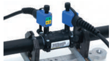
ケーブルの接続
