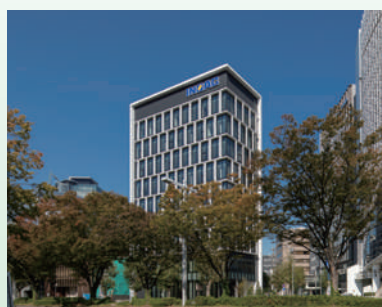
空調利用(地熱トルネード工法)
