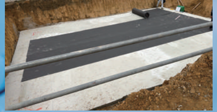
③遮水シート敷設
