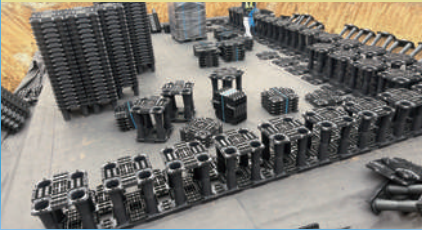
④貯留槽組立
