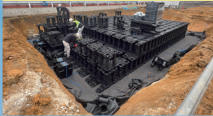
④貯留槽組立
