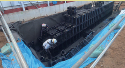
①貯留槽組立
