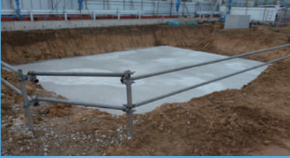
①基礎コンクリート
