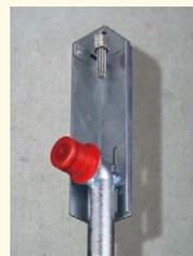
調整金具向きを調整して、固定して下さい。その後、取付エルボを高さ調整して取り付けて下さい。
