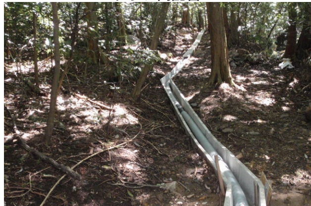
トラフ内配管
