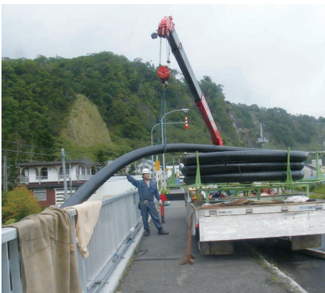
長尺パイプ引込状況
