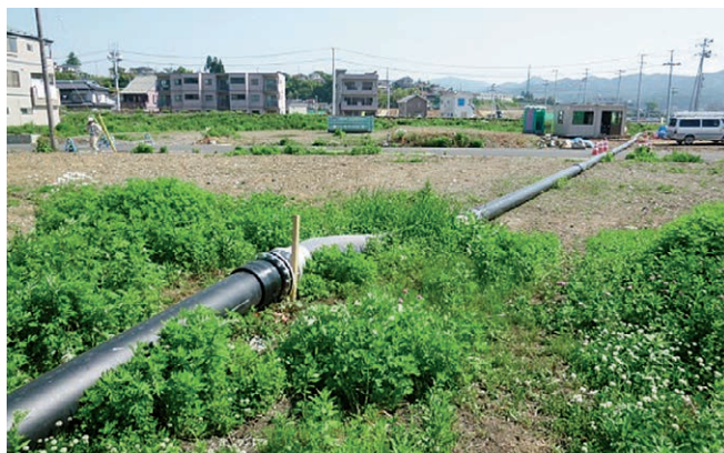
仮設下水配管 (東北震災復興)
