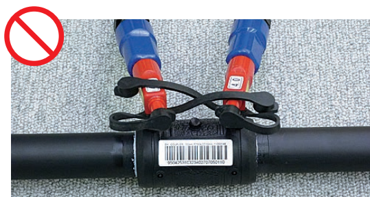
管をクランプで固定せずに融着作業はしないでください。
