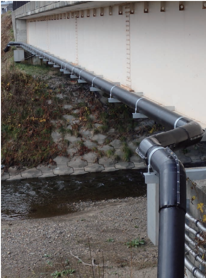
橋梁地覆下配管
