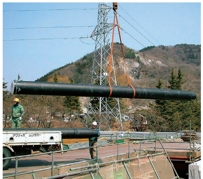
パイプ吊込状況
