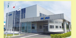
築館工場事務所棟 (ZEB)
